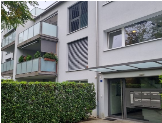
Ansicht von Nordwesten mit Hauseingang
