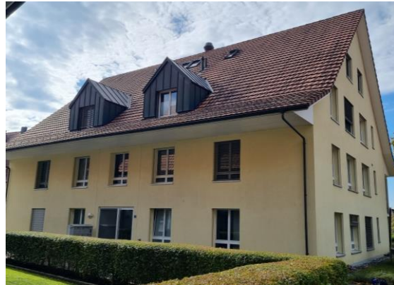
Ansicht von Norden mit Hauseingang
